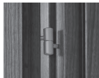
DETAIL ŠPECIÁLNEHO DIZAJNOVÉHO ZÁVESU FALCOVÉHO PŘEVEDENIE UNICO
